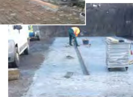
Wiederhergestellte Rottefläche mit In Floor-Betonbelüftungsrohren
