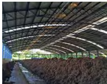
Kompostanlage La Paz, die Rückstände aus der Palmölindustrie verarbeitet
