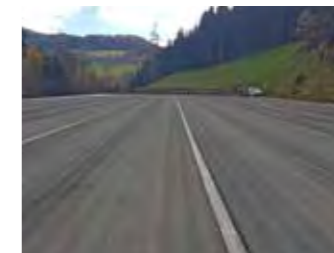
Rottefläche – fertig asphaltiert in wenigen Tagen
