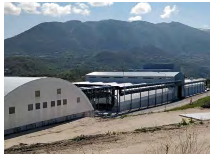
Boxenkompostierung - Trocknungsbox mit integrierter Wärmenutzung der BHKW-Abwärme (Biogasanlage) in Epirus/Griechenland
