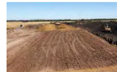
Ertüchtigung der Rottefläche
