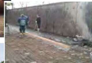
Einbau der Rohre in die bestehende Anlage
