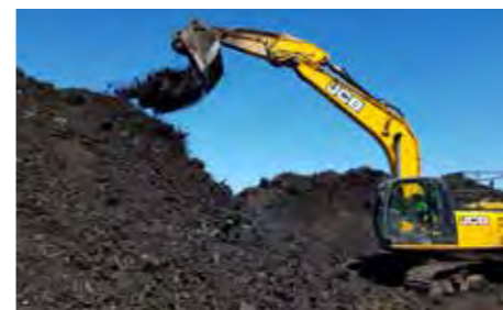
Umsetzen mit Löffelbagger
