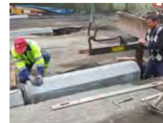
Verlegeteam – 2 Mann + Hebegerät, verlegen die Rohre in einen 80 cm breiten Arbeitsgraben
