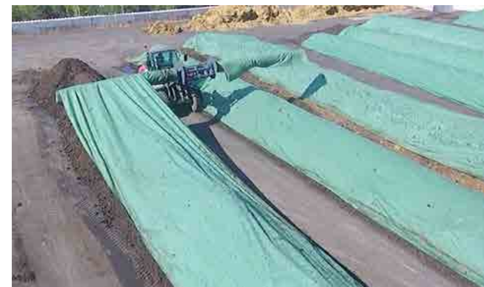
Kompostschutzvlies im Einsatz auf einer österreichischen Anlage
