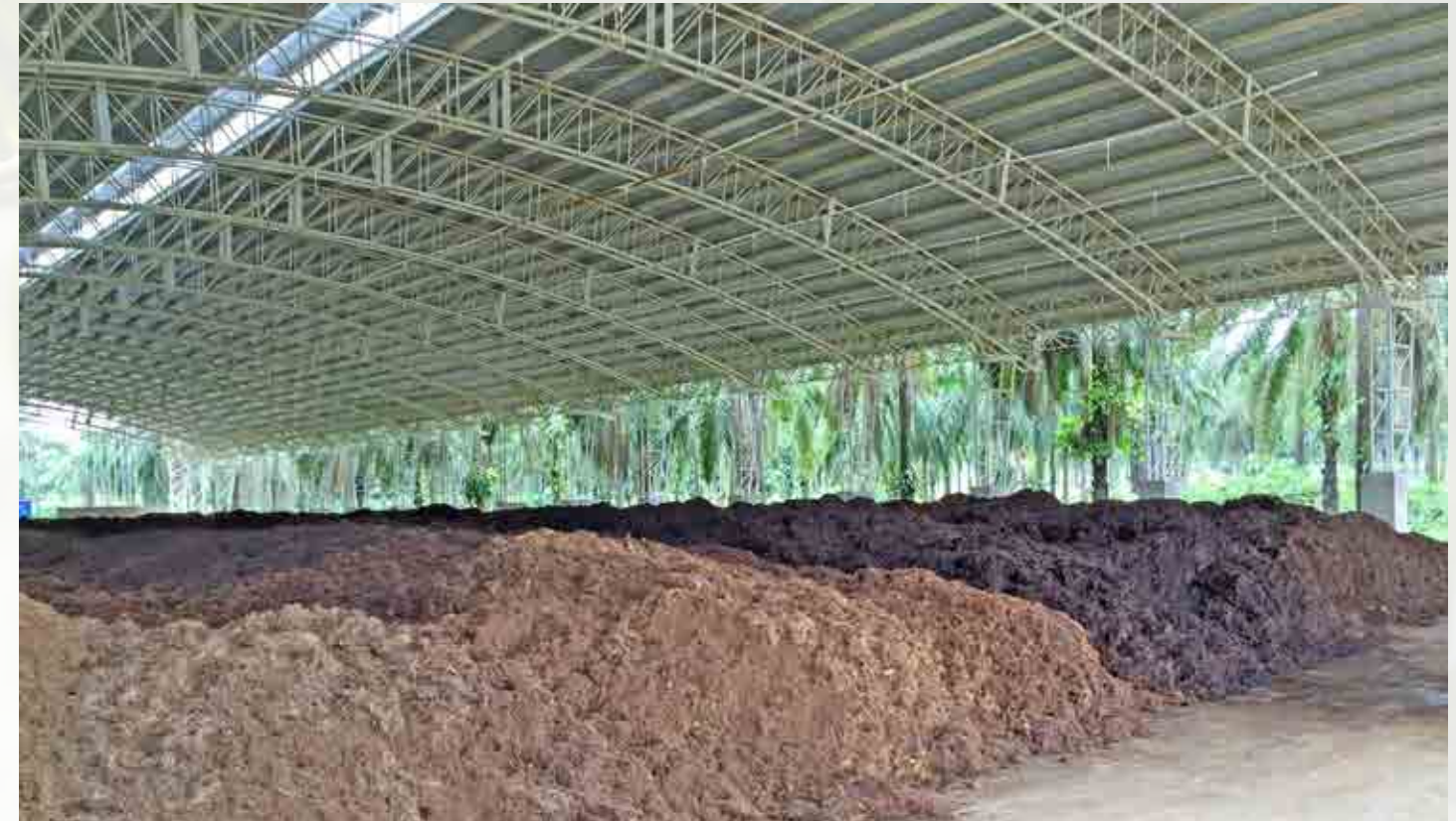
Anlage in Betrieb
