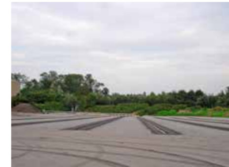
1997 wurde auf der ersten Kompostanlage in Österreich das Belüftungssystem „COMPOnent“ installiert. Heute wird österreichweit auf 15 Anlagen eine Verarbeitungskapazität von mehr als 160.000 Tonnen Klärschlamm pro Jahr kompostiert.
